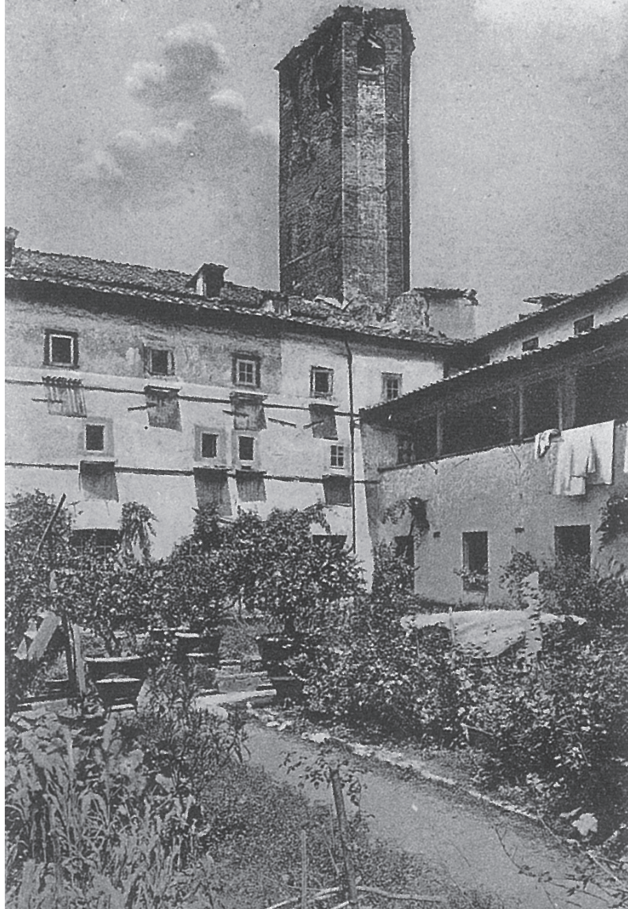
Borgo S. Lorenzo - Terremoto 29 Giugno 1919 Campanile della Pieve dal cortile delle Domenicane.
